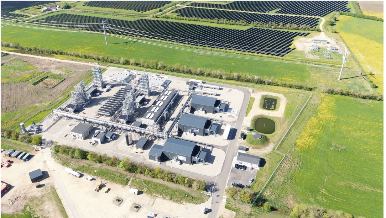
Bild: Syntheseanlage im Solar Park Kassø Aps, © European Energy
